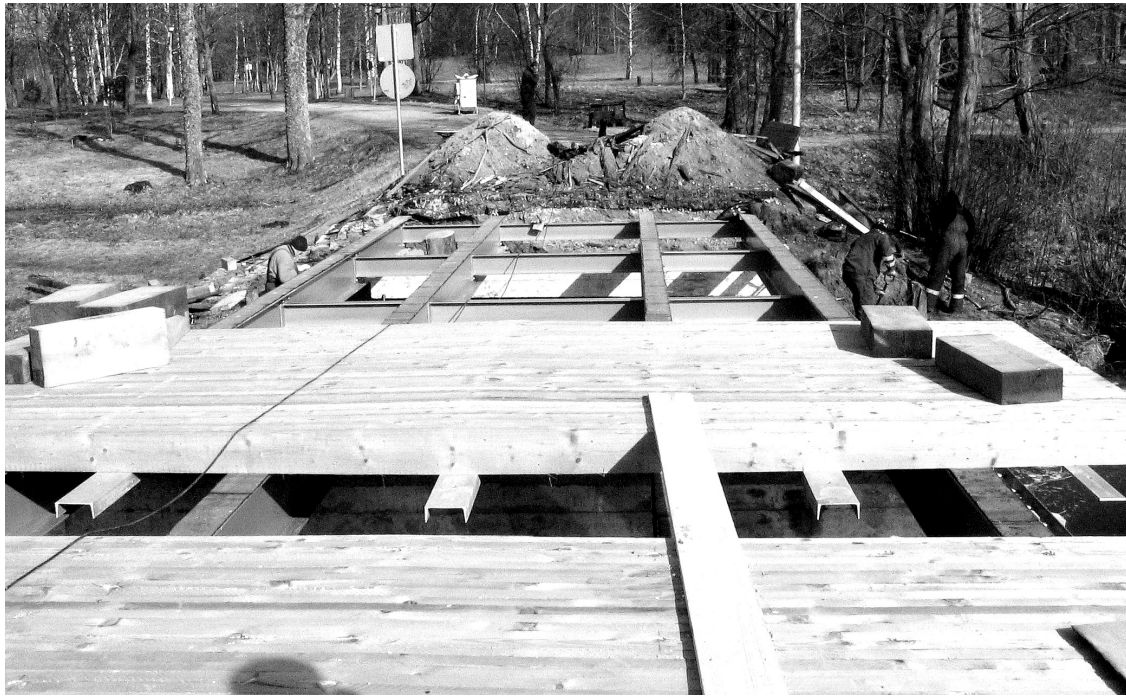
Pagājušajā nedēļā tilta konstrukcijā tika ievietoti pēdējie paneļu metri
