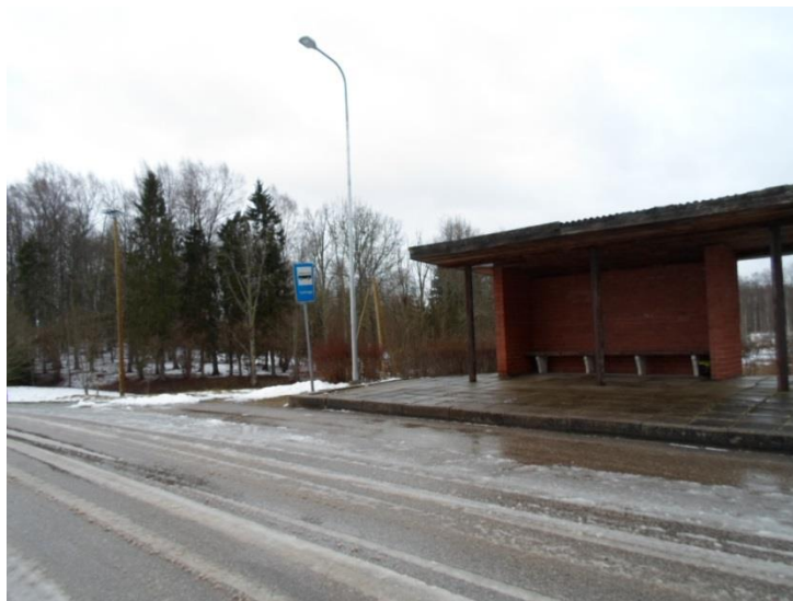
22.attēls. Kalncempju centrā ierīkots apgaismojums
