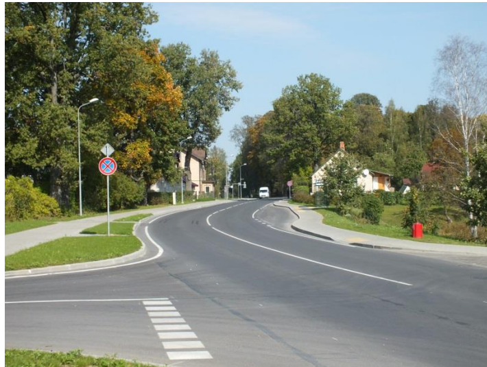
17.attēls. 2014.gadā noslēdzās Pils ielas rekonstrukcijas projekts
