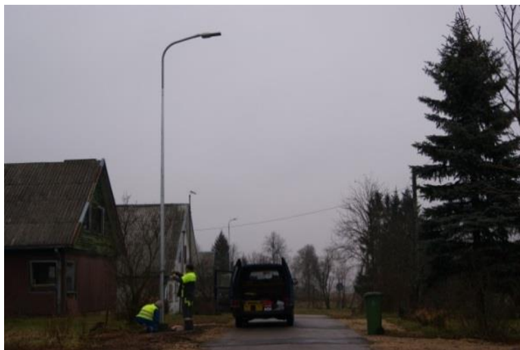
29.attēls. Māriņkalna ciemā veikta ielu apgaismojuma rekonstrukcija
